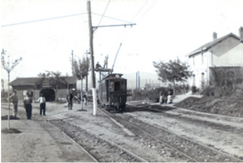
La gare du Tupinier
