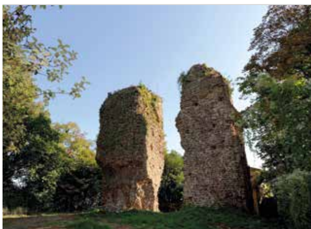
La rénovation des piles d'aqueduc est prévue d'ici la fin du mandat
